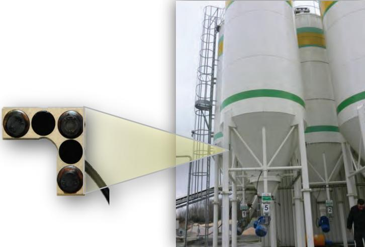
Installation de capteurs L-Strain sur des jambes de silos ronds à l'aide d'onglets de soudure.
